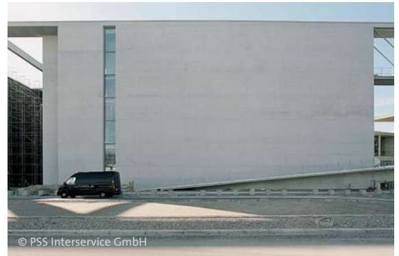
Abb. 15.13b ... und nach der Mängelbeseitigung
