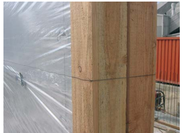
Abb. 11.7 Detailaufnahme: Weder Folie noch Brett berühren den Beton
