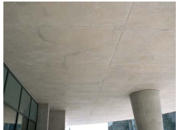
Abb. 14.21 Leicht sichtbare Wolkenbildung an einer Deckenunterseite
