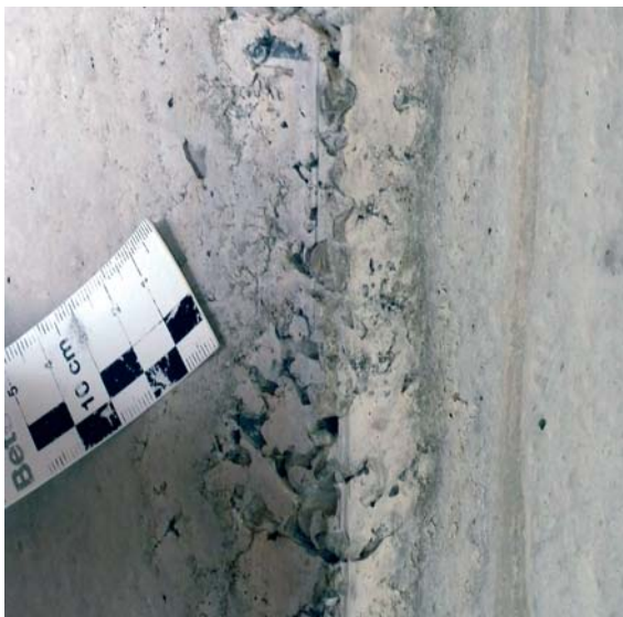
Abb. 14.5 Ausgelaufene Kante
