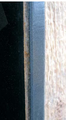
Abb. 6.6 Moosgummi zum Abdichten der Stirnseitenfuge
