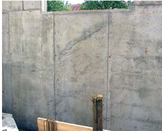
Abb. 14.2 Deutlich sichtbare Schüttagungen
