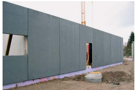
Abb. 2.15 Schwarz eingefärbter Beton am Beispiel der Stadthalle Rottweil
