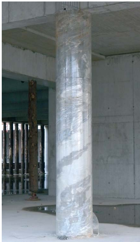
Abb. 11.3 Deutliche Verfärbungen sichtbar
