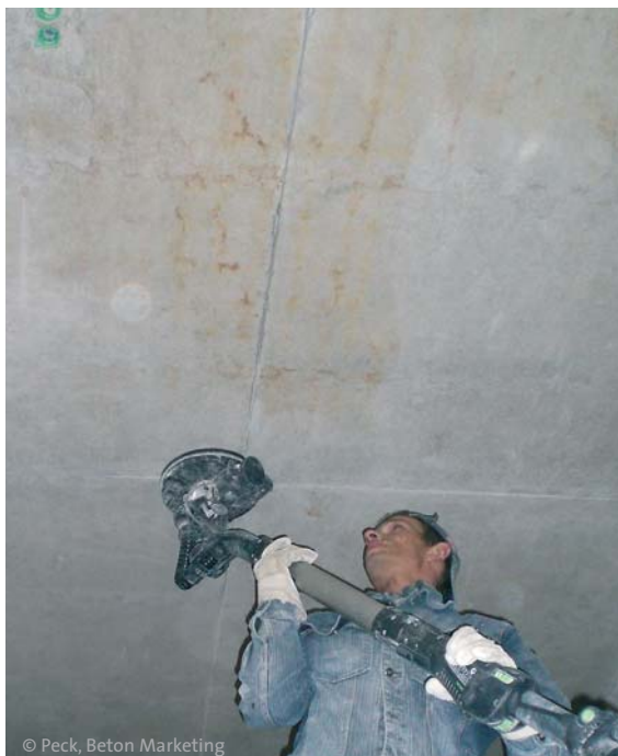
Abb. 15.1 Abschleifen mit Industrieschleifern
