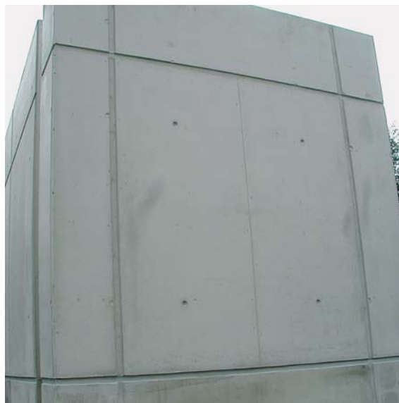
Abb. 6.14 Mit Trapezleisten kaschierte Anschlussfugen
