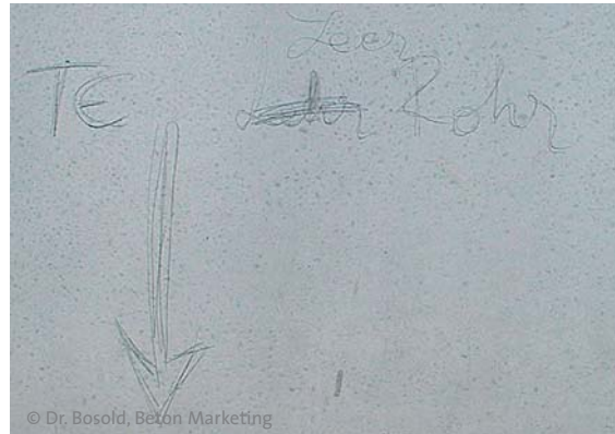
Abb. 15.2 Bleistiftzeichnungen auf der Sichtfläche
