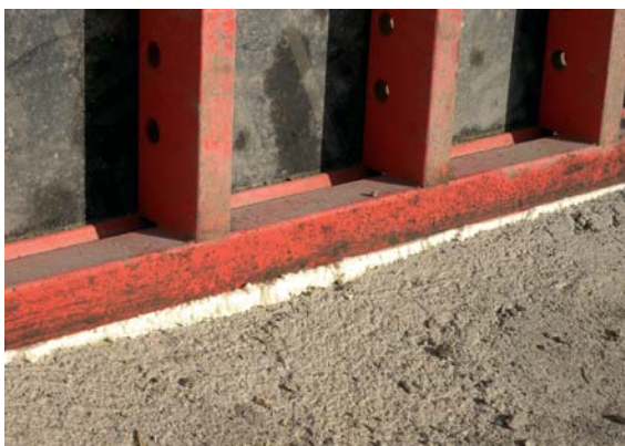
Abb. 6.16 Mit Schaum abgedichteter Schalungsfuß
