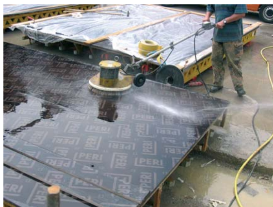
Abb. 6.4 Reinigung der Schalung mit Wasser und Poliermaschine
