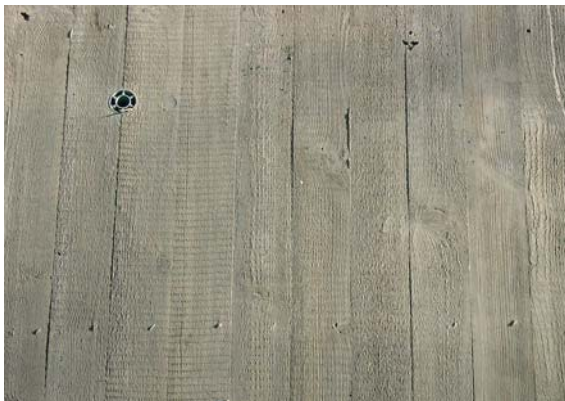
Abb. 2.1 Betonoberfläche mit sägerauer Brettschalung
