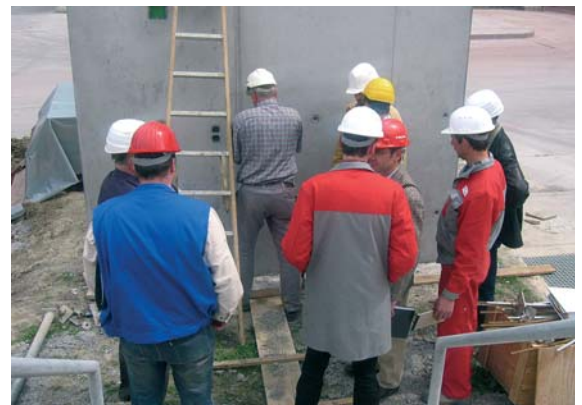
Abb. 7.2 Die Erprobungsfläche wird beurteilt und eine Referenzfläche festgelegt
