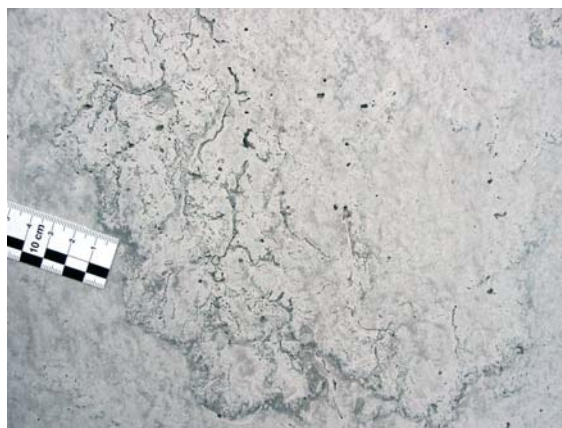
Abb. 14.11 Schleppwasser zeichnet stark ab
