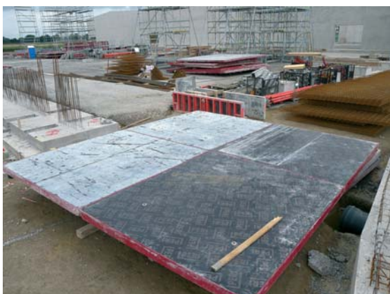
Abb. 6.2 Unterschiedliches Saugverhalten der Schaltafeln
