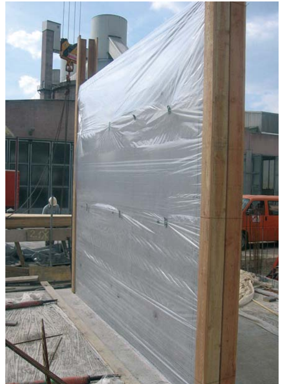
Abb. 11.6 Hilfskonstruktion, um Folienkontakt zu vermeiden
