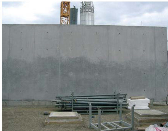
Abb. 9.12 Entmischungen und Farbunterschiede zeichnen sich deutlich ab
