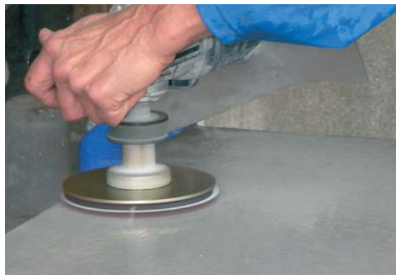
Abb. 15.4 Beton abschleifen mit Schleifmaschine
