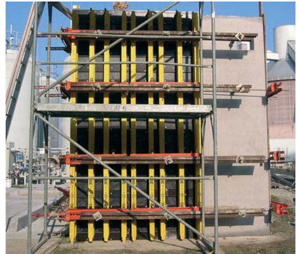
Abb. 7.1 Separat hergestelltes Bauteil, das als Erprobungsfläche dient
