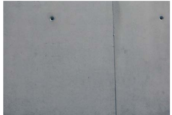
Abb. 5.7 Porenarme Betonoberfläche bei richtiger Trennmitteldosierung
