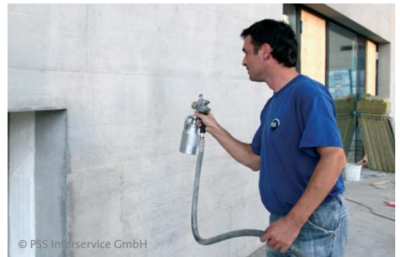
Abb. 15.14b ... einer speziellen Betonlasur. Wohn- und Geschäftshaus »Schänzli- park«, Solothurn
