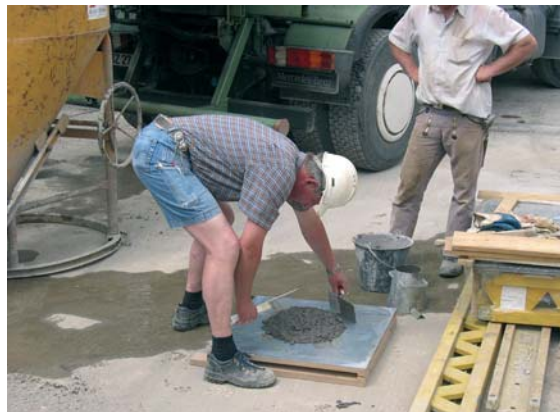
Abb. 8.2 Wichtig: Frischbetonkontrolle auf der Baustelle
