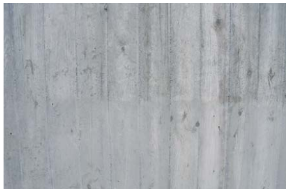
Abb. 14.18 Geringfügige Farbtonunterschiede zwischen einzelnen Schüttilagen
