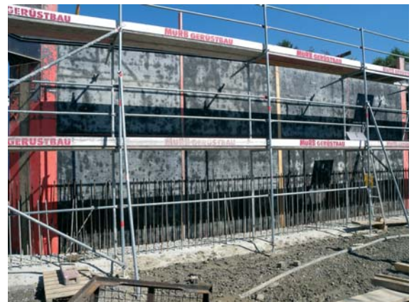
Abb. 5.8 Abtrocknen der gestellten Schalwand
