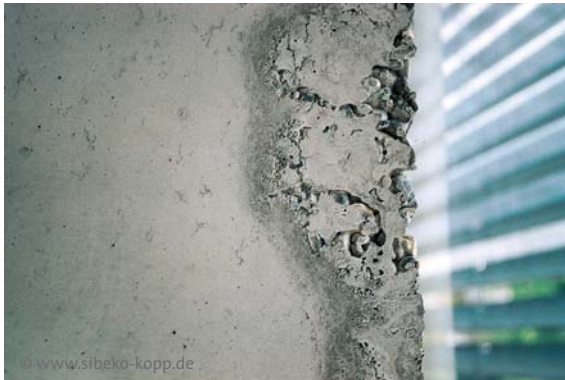
Abb. 15.16a Scharfkantige Ecke mit ausgelaufenem Zementleim vor der Retusche
