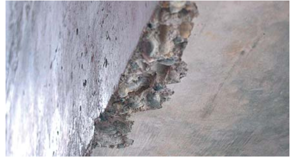
Abb. 10.1 Abgerissene Betonkante
