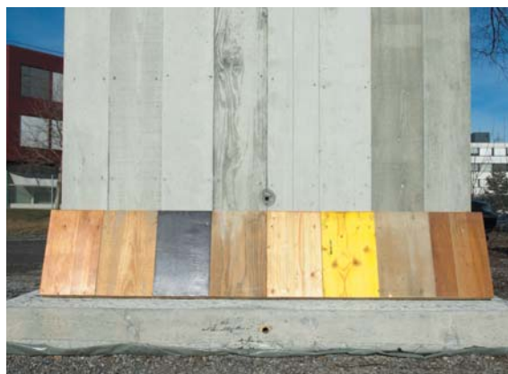
Abb. 2.4 Betonoberflächen mit unterschiedlichen Schalhäuten
