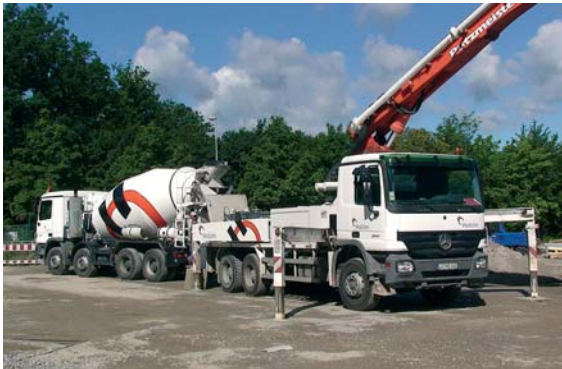
Abb. 9.1 Der Beton muss termingerecht und vor Witterung geschützt geliefert werden
