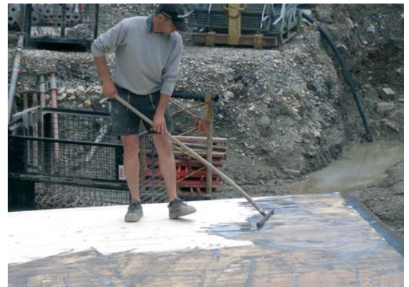
Abb. 4.2 Einschlämmen der Schalung mit Zementleim
