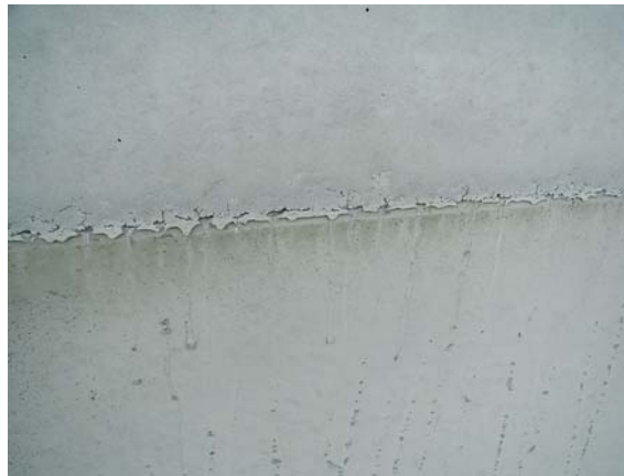
Abb. 6.13 Ausgelaufene Anschlussfuge
