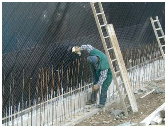
Abb. 5.4 Gleichmäßiges Verteilen des Trennmittels mit dem Lappen
