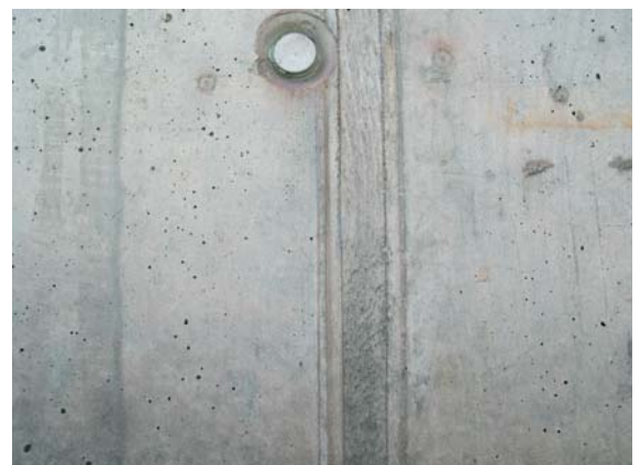
Abb. 14.22 Stellenweise Porenhäufungen und leichte Farbunterschiede am Schalungsstoß
