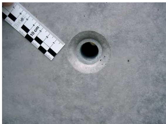
Abb. 6.22 Richtig abgedichteter Schalungsanker
