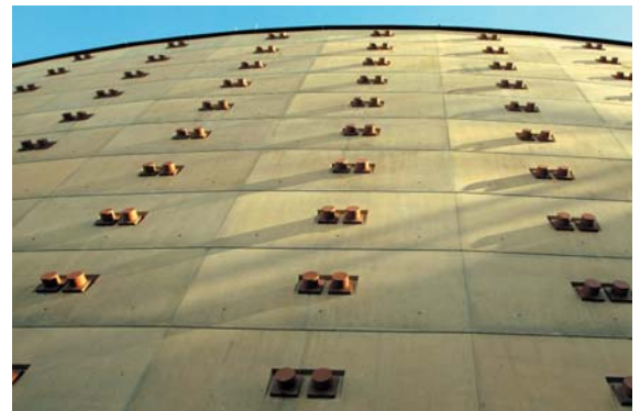
Abb. 2.16 Gelb eingefärbter Beton einer sichtbaren bleibenden Hangsicherung
