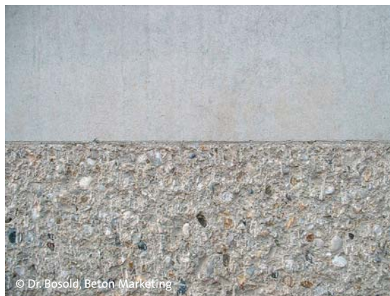
Abb. 2.11 Stocken einer Oberfläche
