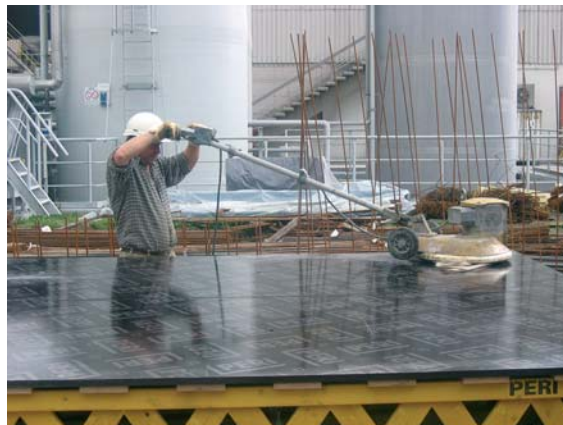
Abb. 5.3 Gleichmäßiges Verteilen des Trennmittels mit der Poliermaschine
