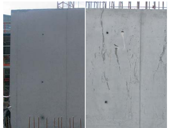
Abb. 9.9 Richtig und schlecht verdichtete Wand – links ohne, rechts mit Entmischungen
