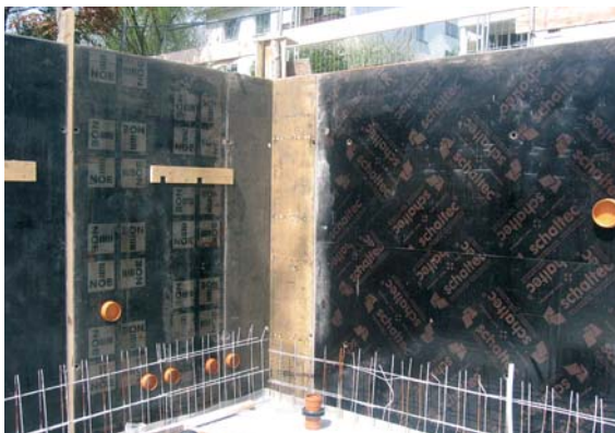
Abb. 4.9 Unterschiedliche Schalhäute
