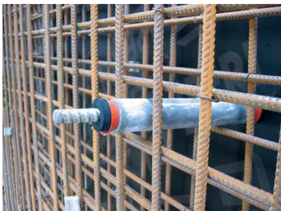
Abb. 6.19 Schalungsanker mit Moosgummi
