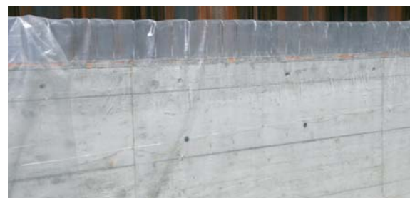
Abb. 12.9 Zwei Beispiele richtig geschützter Anschlussbewehrung
