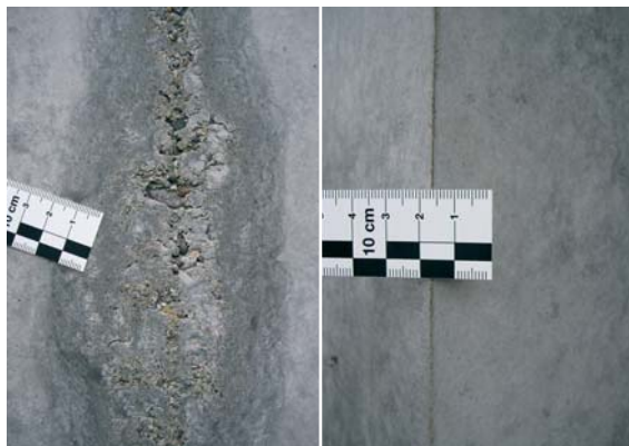
Abb. 6.7 Missratene (links) und geglückte scharfkantige Ecke (rechts)
