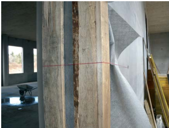
Abb. 12.1 Richtig ausgeführter Kantenschutz mit Brettern und Zwischenlage (Vlies)
