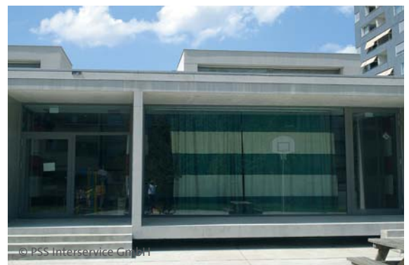
Abb. 15.15b ... lassen sich »wegzaubern«. Schulhaus Hirzenbach, Zürich
