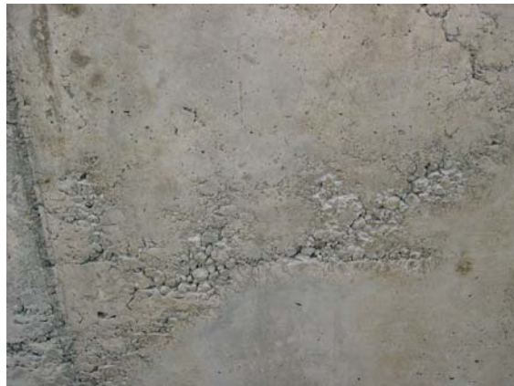
Abb. 14.3 Kiesnest wegen Entmischung
