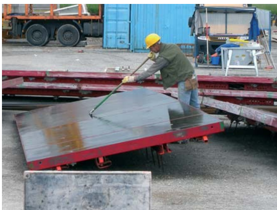
Abb. 5.2 Gleichmäßiges Verteilen des Trennmittels mit dem Gummischaber
