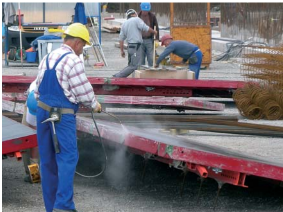
Abb. 5.1 Trennmittelauftrag mit der Spritzdüse
