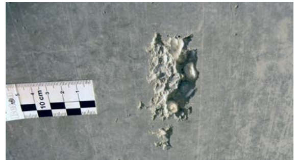
Abb. 10.3 Punktuelle Abriss bis zur Körnung
