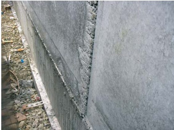
Abb. 14.8 Versatz bei Schalelementstoß
