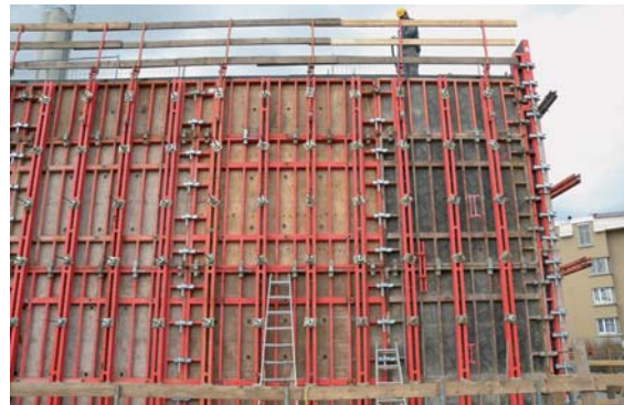
Abb. 3.3 Aufgedoppelte Rahmenschalung
