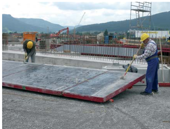
Abb. 6.3 Reinigen der Schalung von Zementresten
