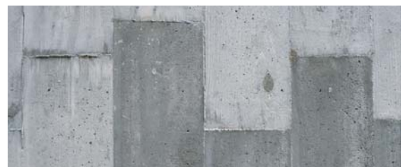
Abb. 4.3 Farbunterschiede durch unterschiedlich alte Bretter
