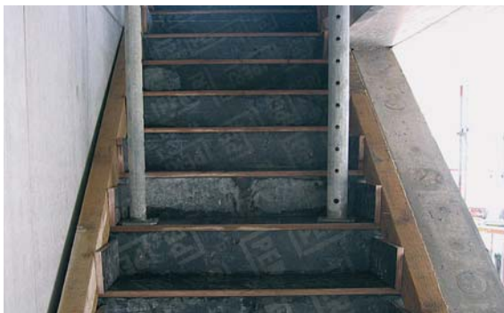
Abb. 12.2 Mit Brettern vor Beschädigungen geschützte Treppe
