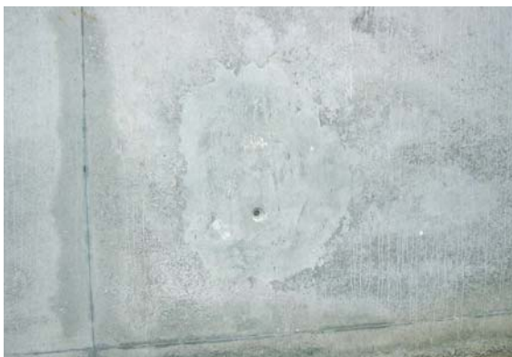
Abb. 15.7 Sichtbare Spachtelung einer Wandfläche
