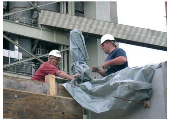
Abb. 12.8 Die Anschlussbewehrung ist mit Kunststoffolie zu schützen
