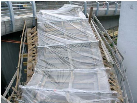
Abb. 11.5 Nach dem Betonieren mit Kunststoffolie eingehaute Treppe
