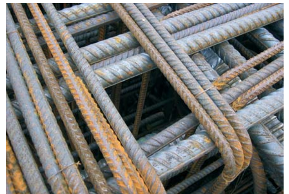
Abb. 9.3 Rüttel- und Einfüllöffnung in der Bewehrung
